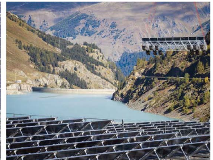
Les 36 structures flottantes supportent 2240 m 2 de panneaux. De quoi produire 800 000 kWh par année, soit l'équivalent de la consommation de 227 ménages.
