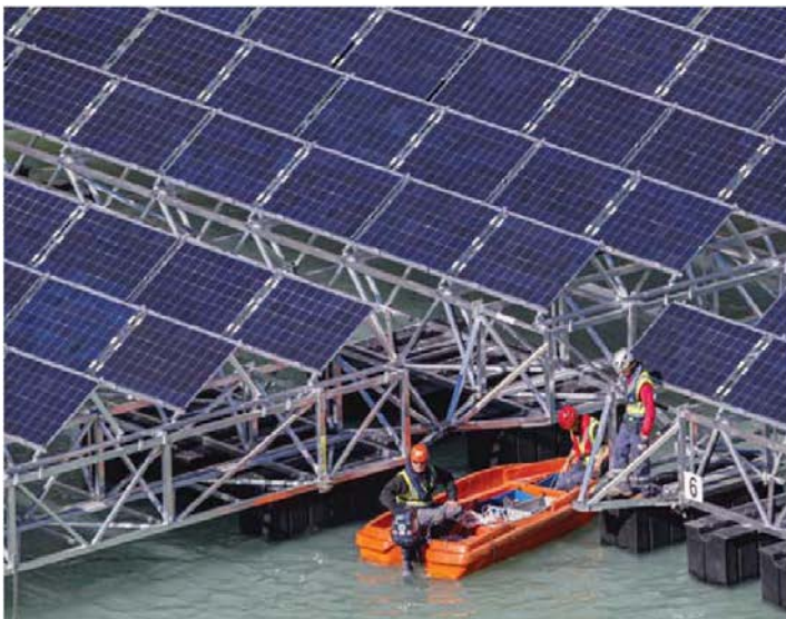
Les 36 structures flottantes supportent 2240 m 2 de panneaux. De quoi produire 800 000 kWh par année, soit l'équivalent de la consommation de 227 ménages.
