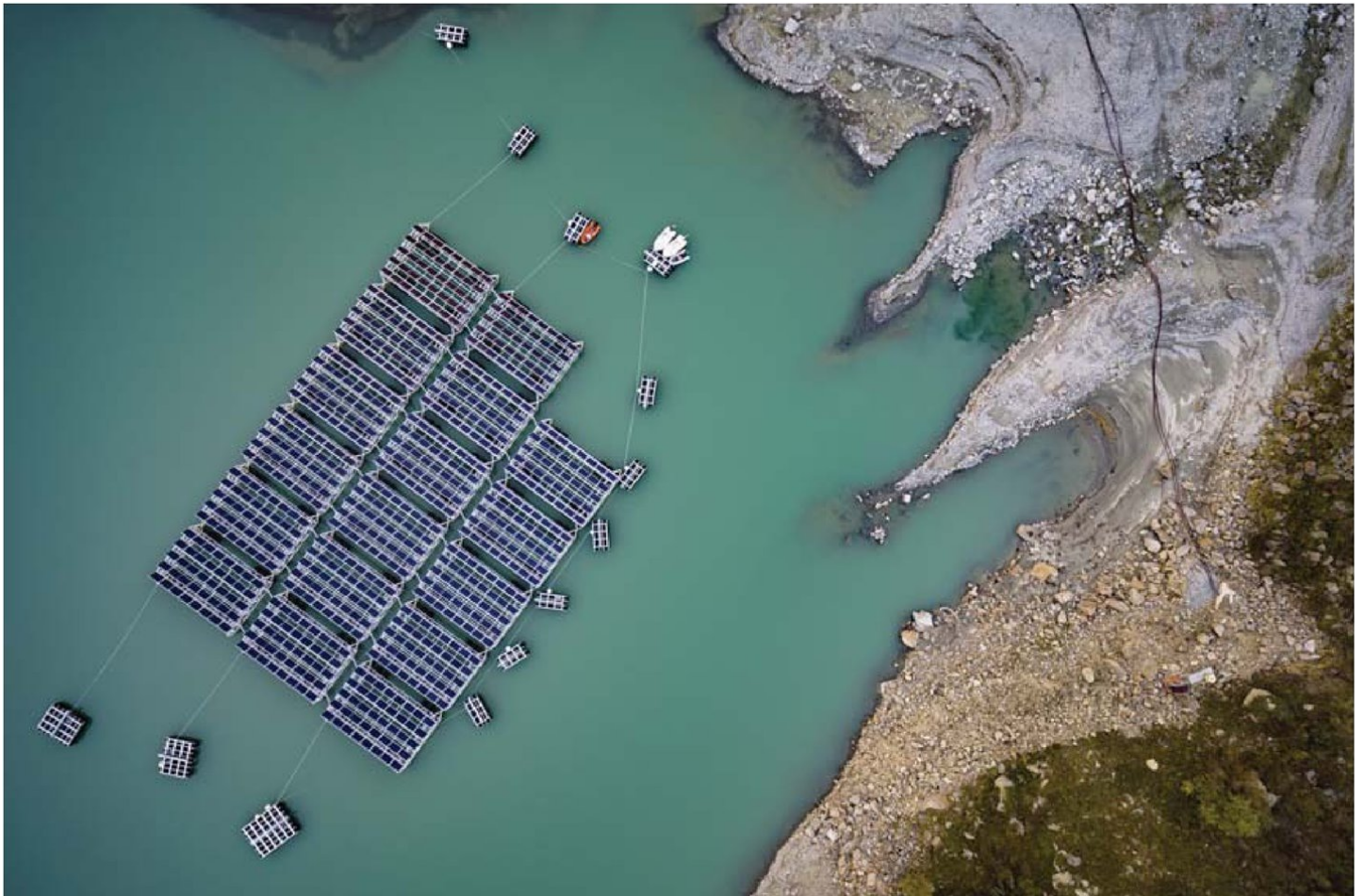
Les panneaux solaires flottent sur le lac des Toules.
